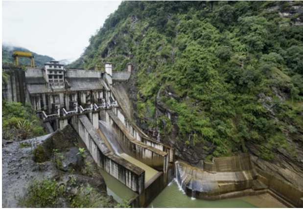
Chuka kraftverket i Bhutan. FOTO: Ken Opprann
