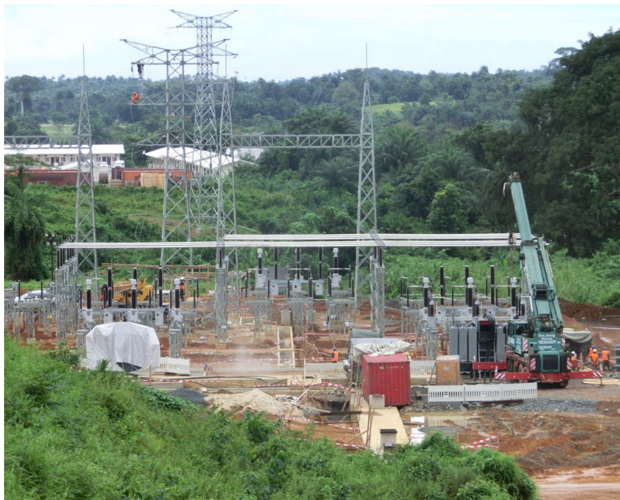
Transformator- og koblingsanlegg under konstruksjon i Monrovia, Liberia. Anlegget fordeler strøm fra Mt. Coffee kraftverket ut på to 66kV kraftlinjer til Monrovia. FOTO: Knut Gakkestad
