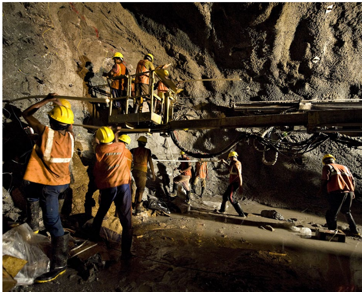
Arbeidslaget som borer hull og laster sprengstoff i full sving med å gjøre klar neste sprengning i Punatshangchhu i Bhutan. FOTO: Ken Opprann
