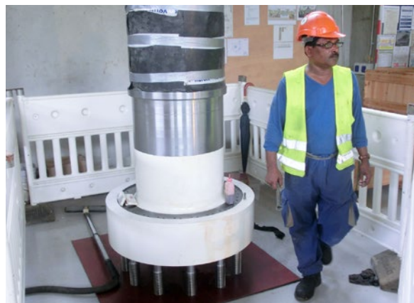
Klargjøring av turbinaksel for montering på Mt. Coffee kraftverket. FOTO: Knut Gakkestad
