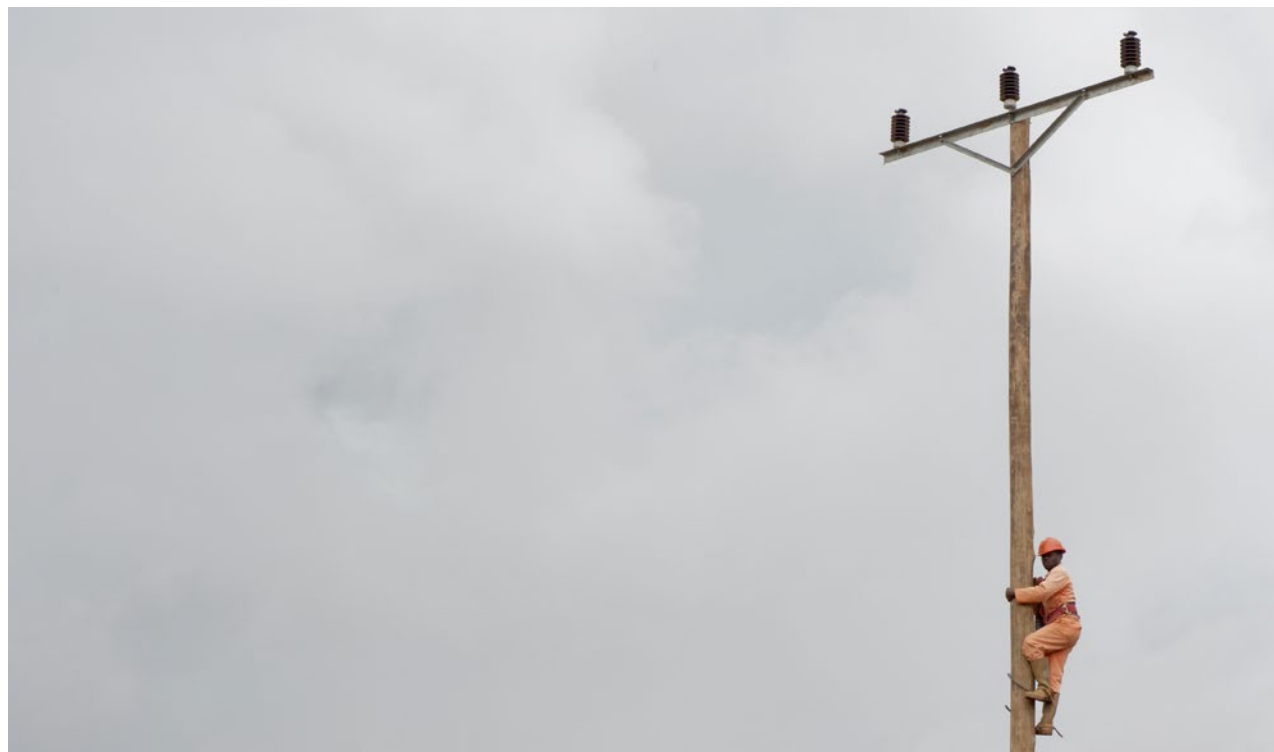
Montering av strømstolper utenfor Lichinga i Mosambik. FOTO: Ken Opprann
